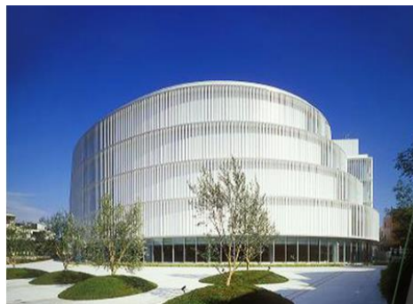
東京ユビキタスビル（東京都中野区）
